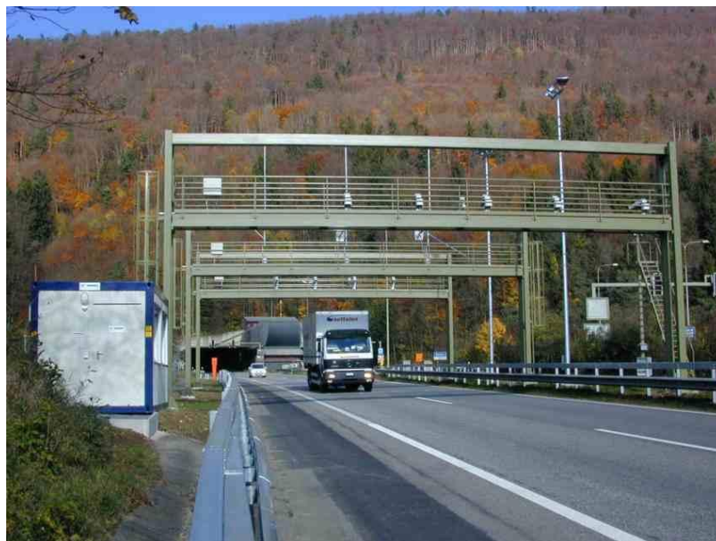
Installation einer automatischen Kontrollanlage
